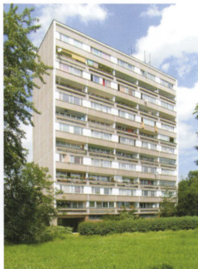
Hradec králové: Tržnice Farmaceutická fakulta Bytový dům Vysokoškolské koleje
